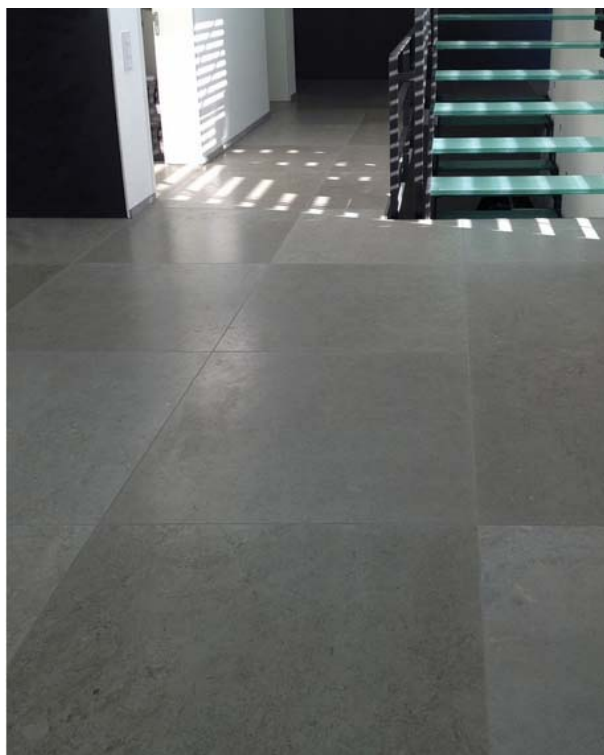
Figura III.58 – Aplicação de Lagos Blue (pavimento) em edifício particular na Suíça.
